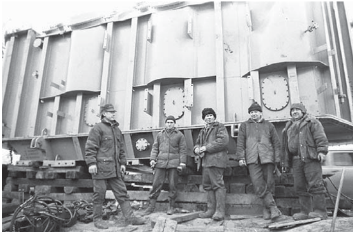
„Transformaator“, Venemaa – Šveits, 2004.
